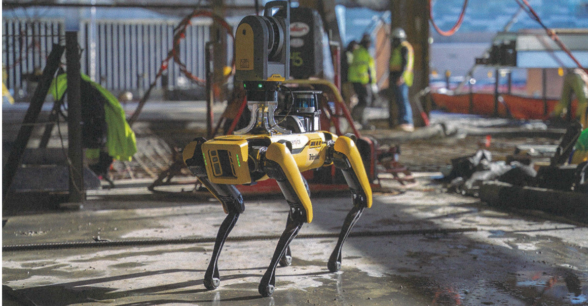
图 1.3: 在建筑工地运行的Spot 在背部安装设备可以进行实地测量。(照片:Boston Dynamics)
